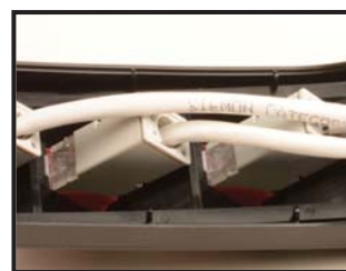
Удобный доступ — Все модули устанавливаются в крышку бокса. Ее можно снять и получить полный доступ к точкам заделки
