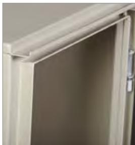
Заковка по периметру дверного проема для усиления жесткости конструкции.
