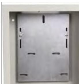
Универсальная монтажная панель под счетчик позволяет без дополнительных переходников установить любые типы однофазных или трехфазных счетчиков.
