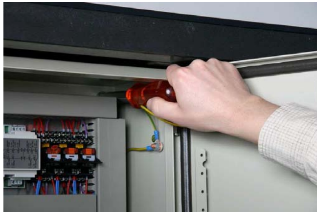
Abbildung: Lösen der Befestigungsschrauben mittels Steckschlüssel
