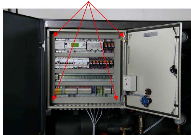
Abbildung: Befestigungsschrauben Schaltschrank
