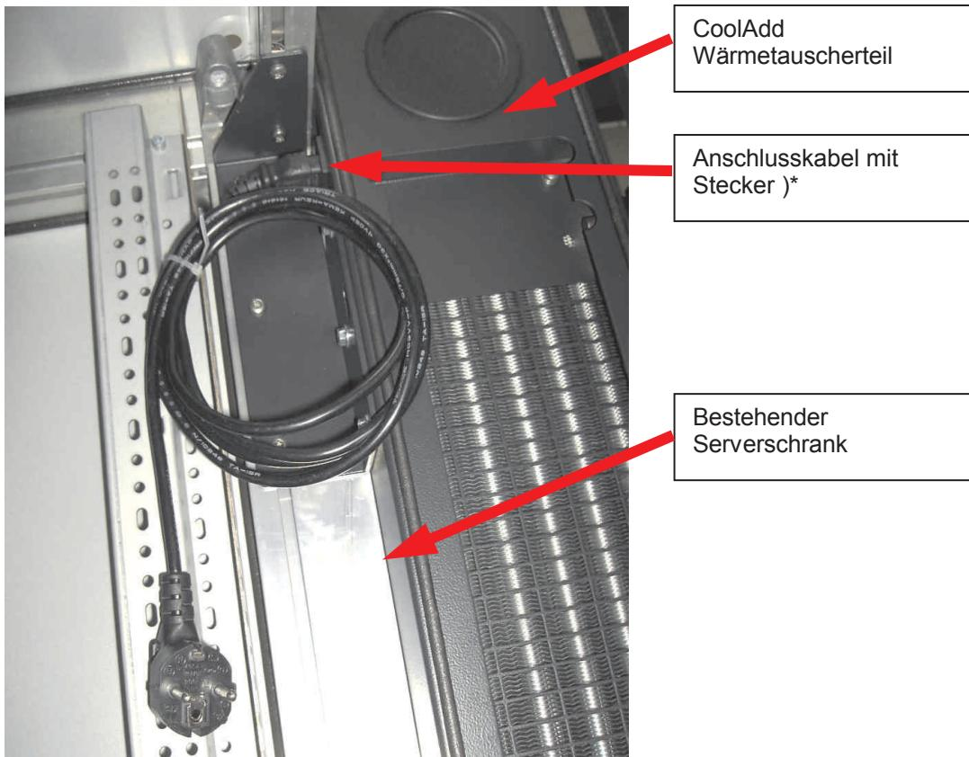
)\* Ausführung je nach Bestellung – Kabel muss separat bestellt werden
