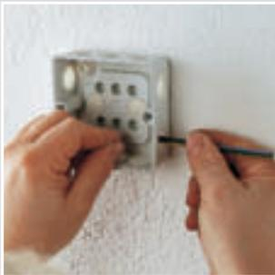
Не требуется дыропробивного оборудования - достаточно просто воткнуть провод.
