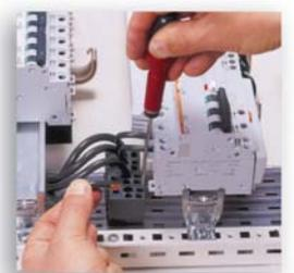
Присоединения выполняются при помощи ответвительных клемм Ø 6 и 10 мм<sup>2</sup>.
