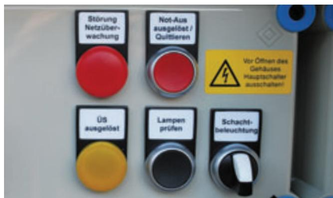
Держатели и шильдики поставляют в виде комплектов наиболее распространенных размеров и версий, рассчитанных на устройства управления и сигнализации Siemens (тип 35B) или ABB (тип ONFB72).
