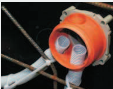
Смонтированные гибкие трубы в корпусе KBT.
