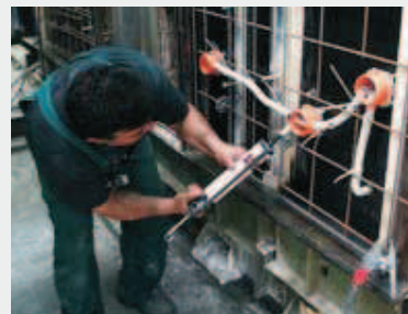
Герметизация вводов (шпатлёвка).
