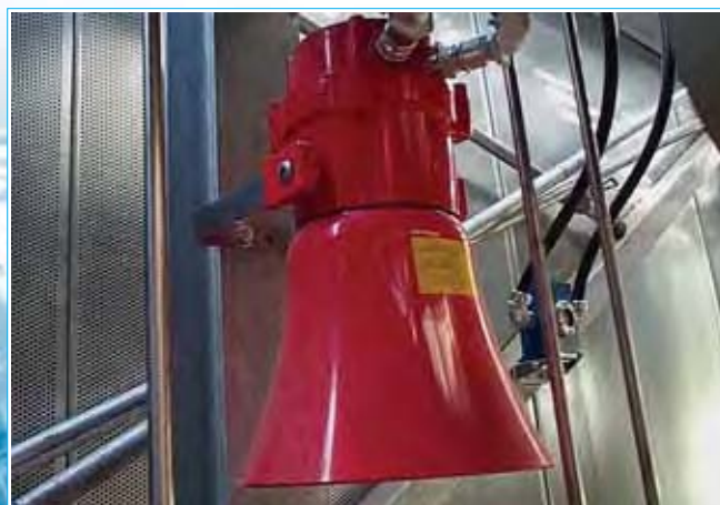
Звуковая сигнализация на газовой электростанции: звукоизлучатель Ex BExS120 ATEX
