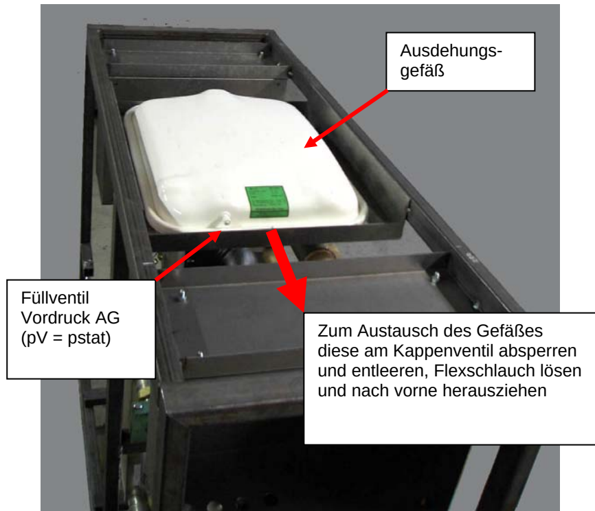
Abbildung: Ausdehnungsgefäß
