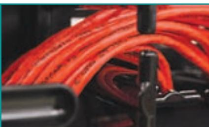
Все детали органайзеров в вертикальных каналах специально закруглены, чтобы патч-шнуры можно было прокладывать без сопротивления и риска повреждения или деформации.
