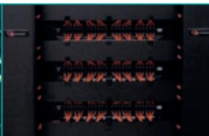
С использованием вертикальных каналов коммутации VPC и горизонтальных кабельных органайзеров серии RS компании Siemon можно идеально упорядочить все кабели и шнуры
