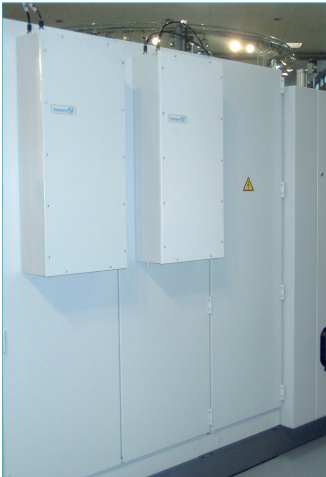
Воздушно-водяные теплообменники Pfannenberg серии PWS
