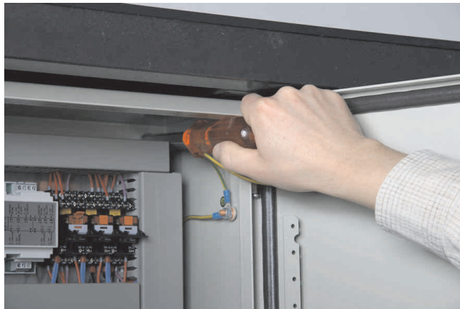
Abbildung: Lösen der Befestigungsschrauben mittels Steckschlüssel
