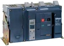
Устройство ввода резерва на большие токи Masterpact NW или Micrologic
